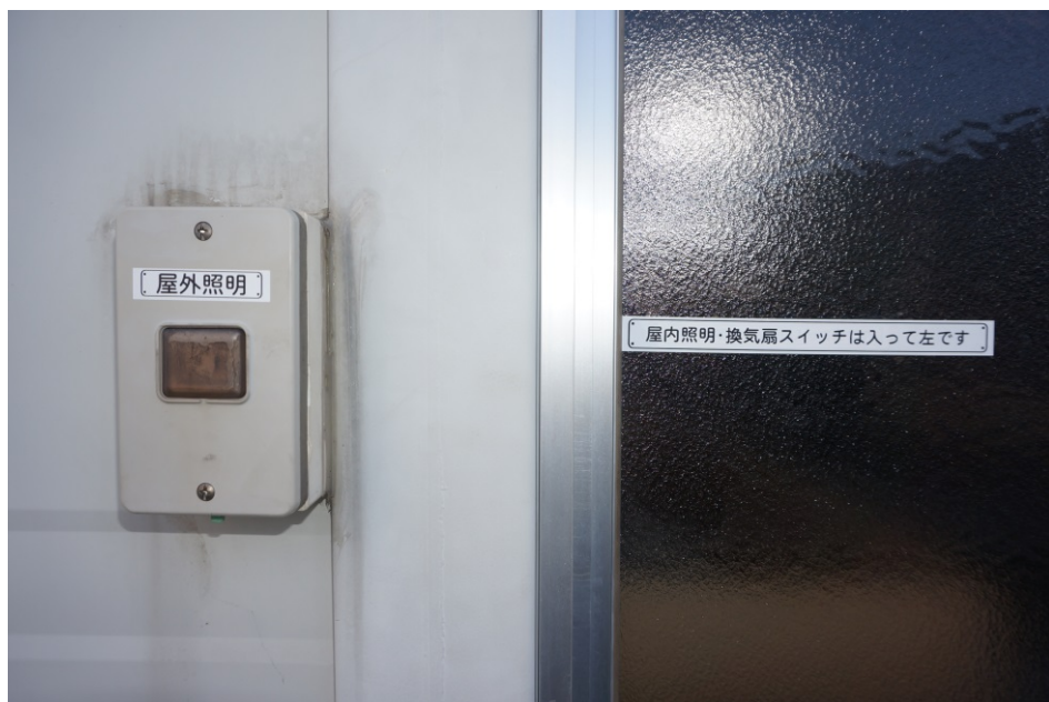
西側の屋内照明・換気扇スイッチ
