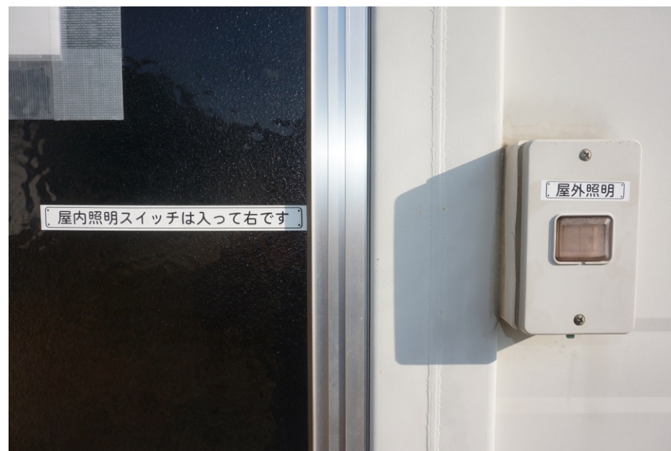
南側の屋内照明スイッチ
