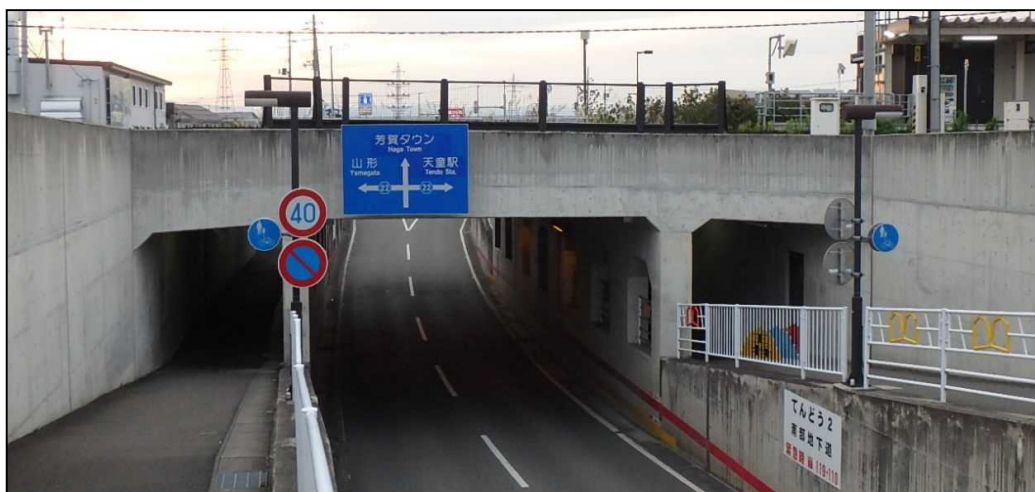
市道 松城芳賀線 南部地下道
