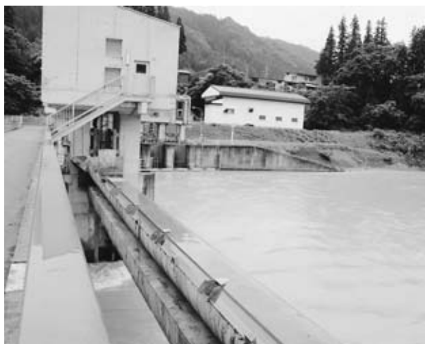
西川浄水場（西川町）
