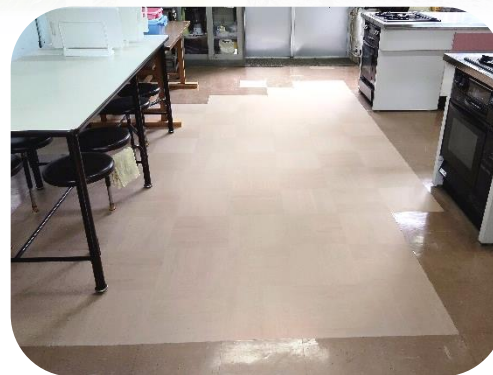
調理室の床（改修後）
