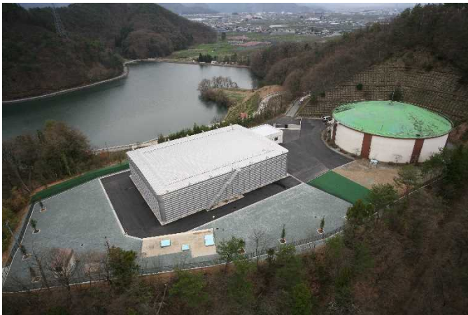
八幡山配水場
