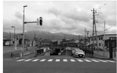
▲工事予定の南部地下道
