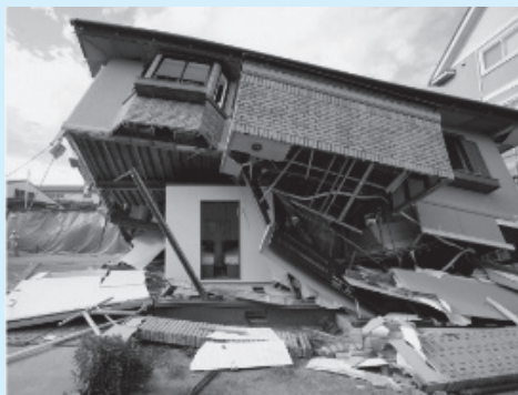
▶耐震シェルター (写真中央)
