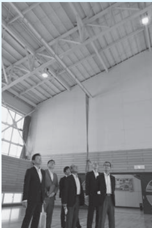
▲LED照明への交換を行った体育館
