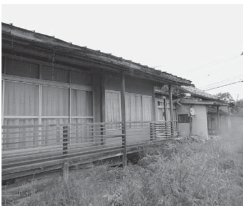
▲写真の空き家は解体後、分譲地として利活用
