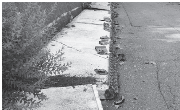
▲6月18日発生地震により鶴岡市内で倒壊したブロック塀
