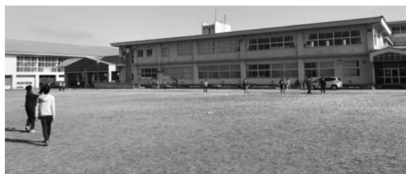
▲改修工事予定の高嶺小学校グラウンド
