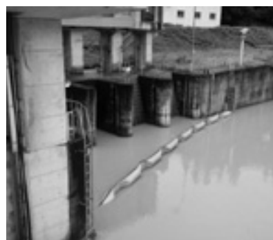
▲村山広域水道西川浄水場の取水口
