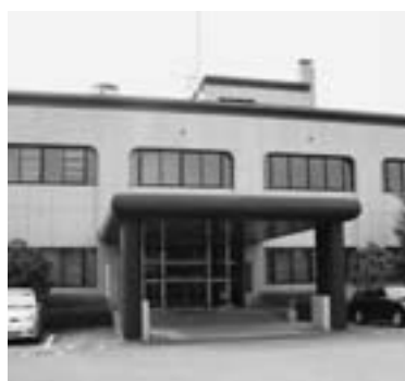
最上川流域下水道山形浄化センター(大町)
