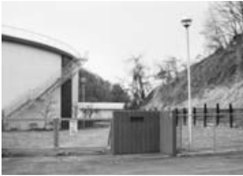
増設計画のある八幡山配水池
