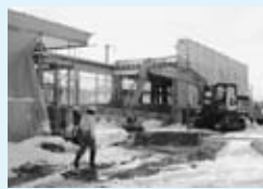
▲工事中の天童南駅
